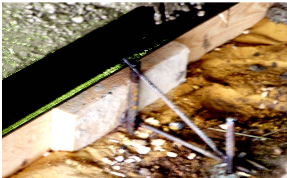
Рис. 11. Схема приваривания уголков опалубки к анкерам
